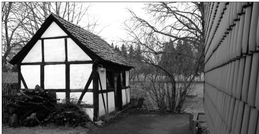
Das Backhaus in Evessen - „Dieter“
